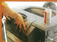
新しくなった煙突接続パーツも取り付け完了!
