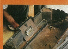
給気口のふたとサーモスタッドを取り付け
